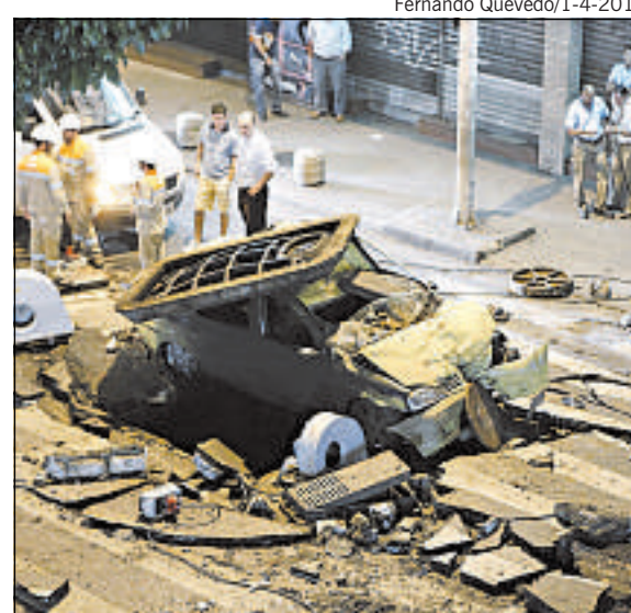
ESTRAGOS CAUSADOS pela explosão de um bueiro
